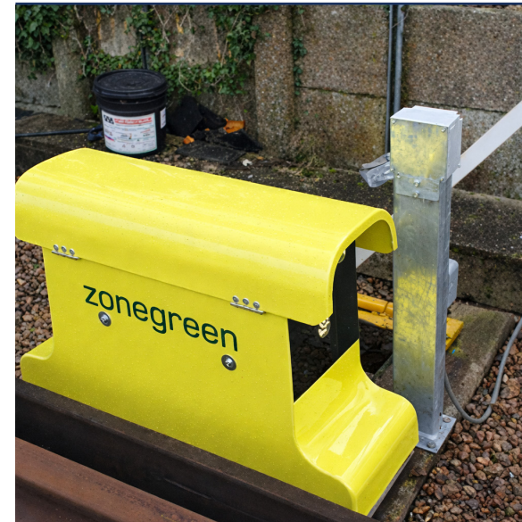
Makas Dönüştürücü: Makas konum verilerini dijitalleştirerek Depo Yöneticisi SCADA yazılımına aktaran entegre kontrol ünitesidir.
